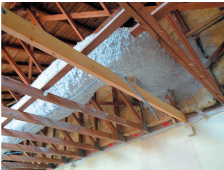
← Pose des tuyaux d'évacuation avec calorifuge
